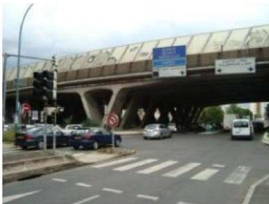
Entrée de ville D5 et le pont de l'A86
