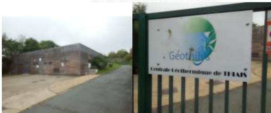
La centrale géothermique de Thiais
