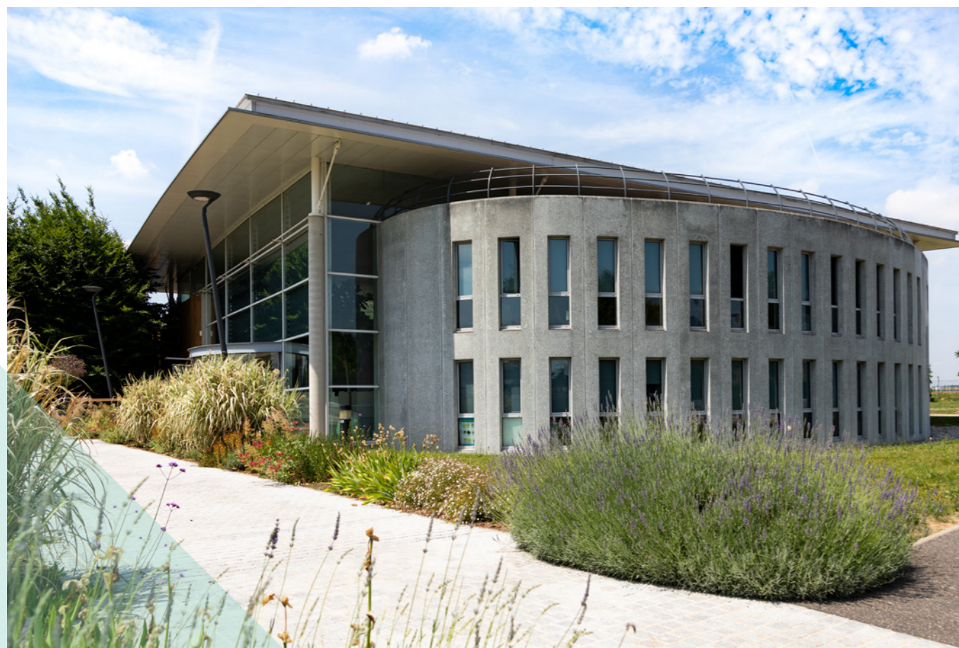
Vue extérieure de la Maison de l'Environnement et du Développement durable de Paris-Orly.
