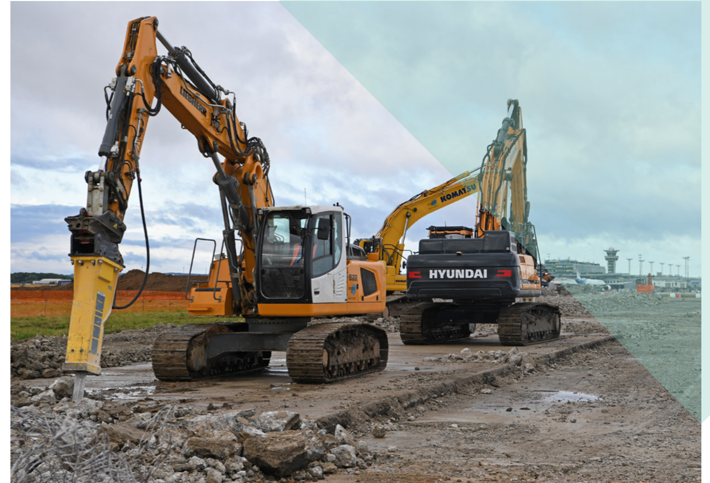
Travaux de rénovation d'infrastructures sur l'aéroport Paris-Orly.
