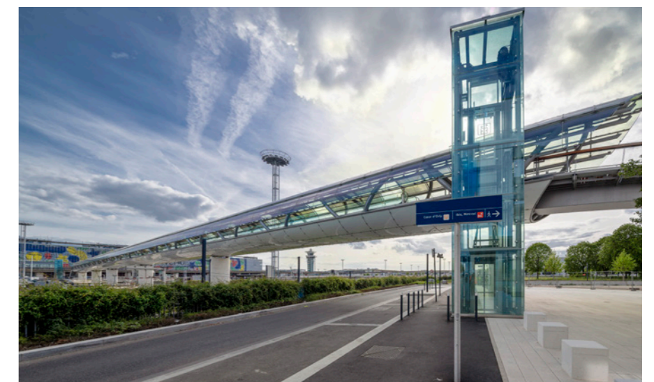
Vue de la passerelle Cœur d'Orly, Paris-Orly.
